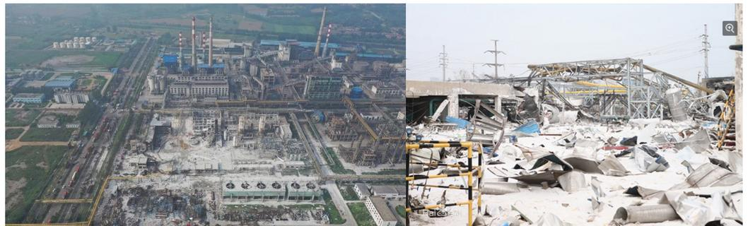
通過初步調查發現：2019年6月26日發現C套空氣分離裝置冷箱保溫層內氧含量上升，判斷存在少量氧洩漏，但未引起足夠重視，認為監護運行即可；7月12日冷箱外表面出現裂縫，洩漏量進一步增大，由於備用空分系統設備不完好等原因，企業卻仍堅持「帶病」生產，未及時採取停產檢修措施，直至7月19日發生爆炸事故。
