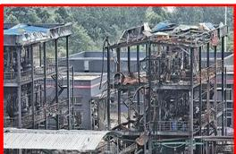
直接原因: 宜賓恒達公司在生產咪草煙的過程中,操作人員將無包裝標識的氯酸鈉當作丁醯胺,補充投入到2R301反應器中進行脫水操作。在攪拌狀態下,丁醯胺氯酸鈉混合物形成具有迅速爆燃能力的爆炸環境,在操作條件下,丁醯胺/氯酸鈉混合物發生化學爆炸,爆炸導致反應器解體;隨反應器解體過程沖出的高溫甲苯蒸氣,迅速與外部空氣形成爆炸性混合物並產生二次爆炸,同時引起工作現場存放的氯酸鈉、甲苯與甲醇等物料爆燃爆轟和第二個工作間、第三個工作間起火燃燒,進一步擴大了事故後果,造成重大人員傷亡和財產損失。
